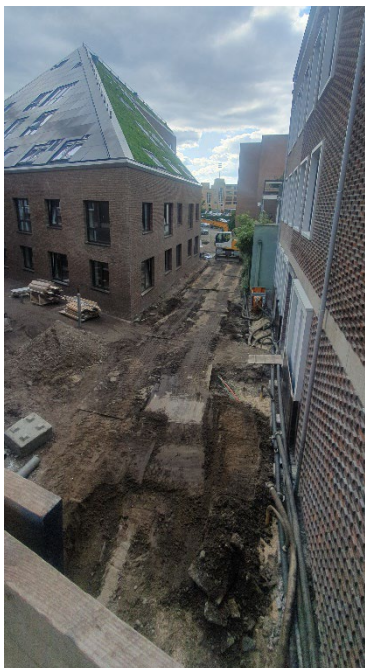
Infrawerkzaamheden rondom Orange
