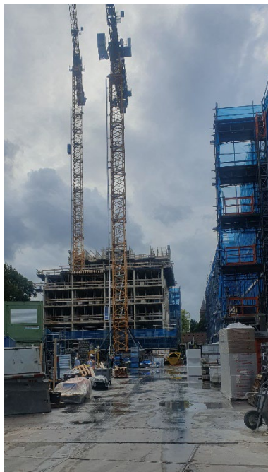
Aanzicht gebouw Violet
