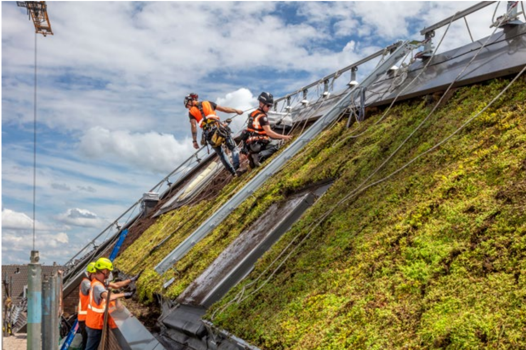
Foto gebouw Orange, aanbrengen groen dak d.d. 9 juli 2024
