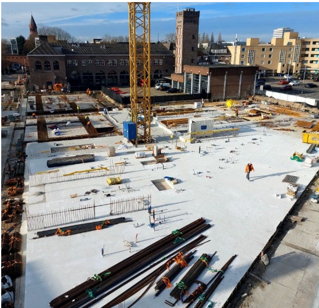
Foto d.d. 4 maart 2024 – gebouw Rouge, begane grond is gereed
