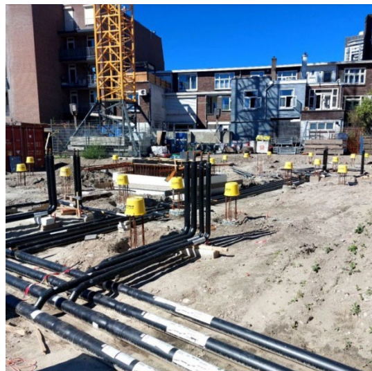
De koude/warmteleidingen voor gebouw Orange zijn gereed
