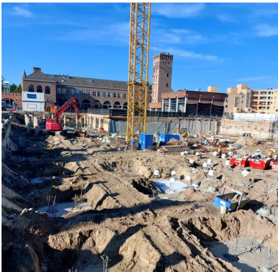
Poeren stallingsgarage deels gestort
