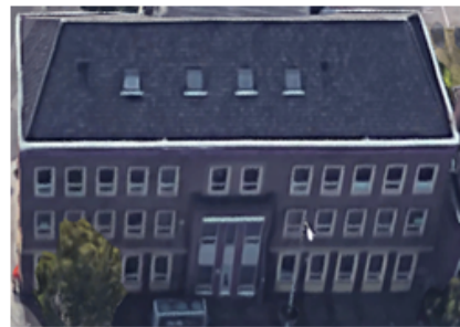
afbeelding : gebouw 7 bestaand
