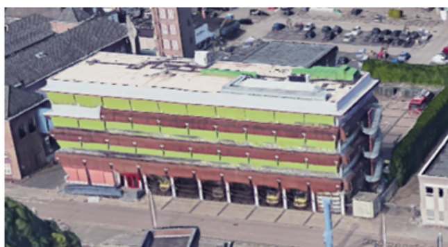
afbeelding : gebouw 3 bestaand
