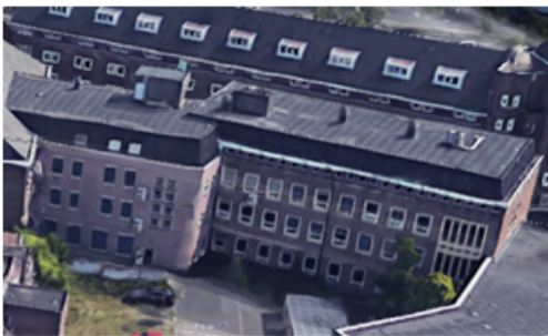
afbeelding ; gebouw 6 bestaand
