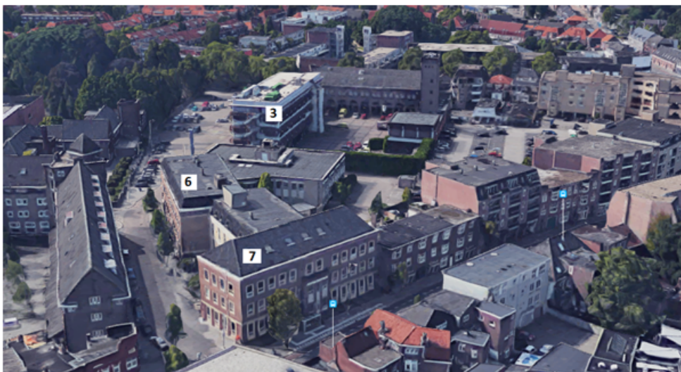
afbeelding : te transformeren gebouwen 3, 6 en 7
