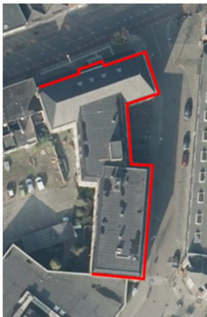
afbeelding : vanaf openbare weg zichtbare gevels gebouw 6 en 7
